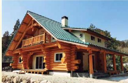
県産材を使い、杉の厚板を用いる板倉工法の壁や土佐漆喰で仕上げ、断熱材も杉の皮を使用。自然に還る素材を100%使って建てるログハウスです。
