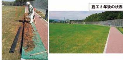
従来の透水型U字溝や埋設型の透水管の代わりに、特殊なフラッシングコア（濾過構造体）を使い、側面から給排水する画期的な排水工法。
