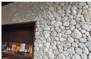
外壁から続く石灰石の内壁
