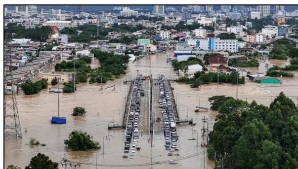
立体交差上に避難した車が立ち並ぶ
