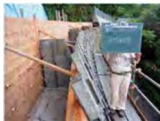
目地部に使われる木製型枠の代替材の埋設型枠
