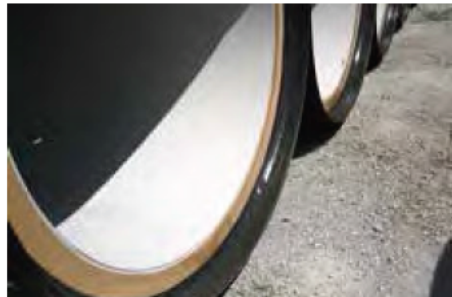
TS シールを下水道管端面に充填
