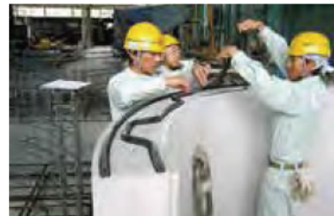
落差マンホール接合用 TS シールテープの貼り付け作業
