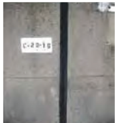
防潮堤の目地に充填
