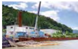
大船渡永浜地区海岸防潮堤工事 (岩手県大船渡市)
