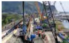
高知海岸堤防改良工事 仁ノ工区 (高知県高知市)
