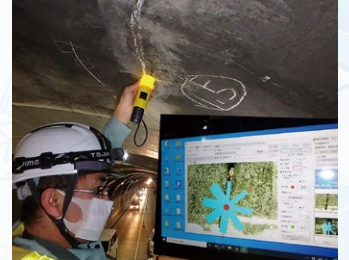
現場での計測風景
