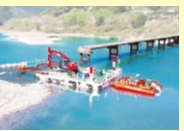
四方十川岩間沈下橋復旧工事
