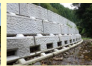
プレキャストコンクリート製品を使用した護岸整備
